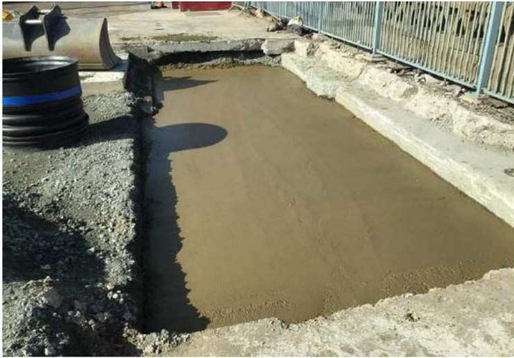
Concrete pour on the South Pier.
